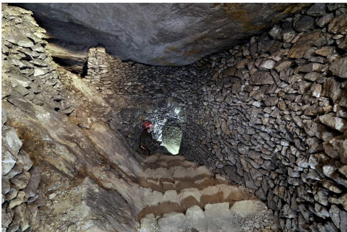
ÚKLONNÁ CHODBA – ÚPADNICA VYTVORENÁ VO VYDOBYTÝCH PRIESTOROCH S BOČNÝMI STENAMI POSTAVENÝMI Z VOĽNE UKLADANÝCH KAMEŇOV. PRIESTOR ZA NIMI JE ZALOŽENÝ HLUŠINOU.
