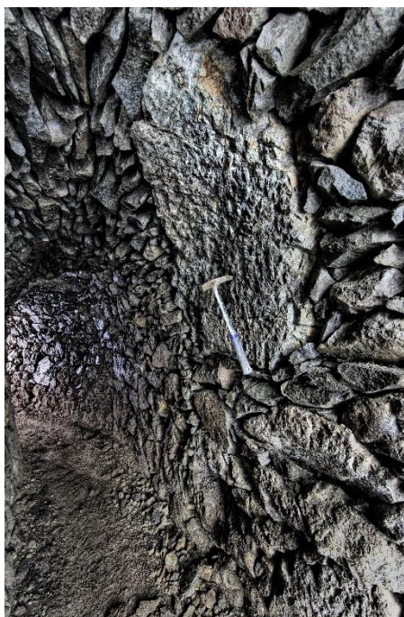
MUROVANICA, CHODBA VYBUDOVANÁ V OTVORENÝCH VYDOBYTÝCH PRIESTOROCH Z VOĽNE UKLADANÝCH KAMEŇOV
