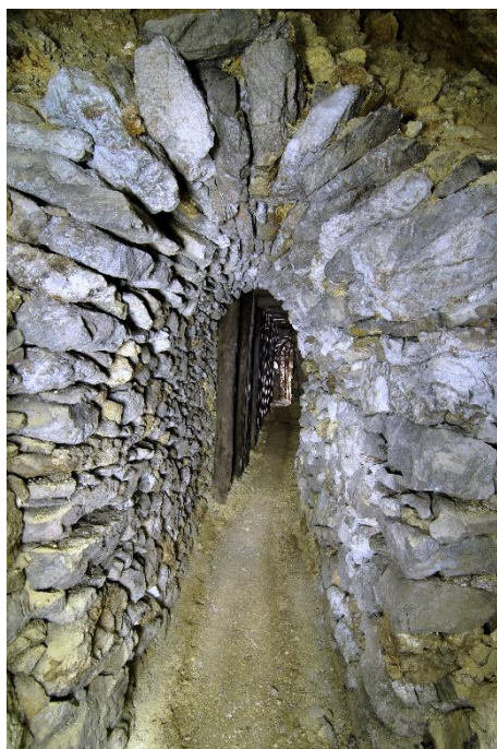
MUROVANICA, CHODBA VYBUDOVANÁ V OTVORENÝCH VYDOBYTÝCH PRIESTOROCH Z VOĽNE UKLADANÝCH KAMEŇOV
